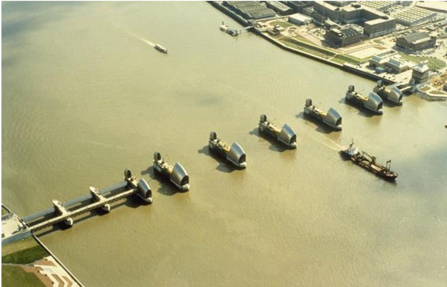
Σχήμα 3.36 Το φράγμα του Τάμεση (Thames Barrage) που έγινε για να προστατεύσει τον ποταμόκολπο από πλημμύρες σε περιπτώσεις μεγάλης φουσκοθαλασσιάς η γενικότερης αλλαγής της θαλάσσιας στάθμης. (Τροποποιημένο από SEPM, 1996).
