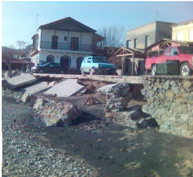
Σχήμα 11. 20 Διάβρωση παραλιών από άστοχα παράκτια έργα όπως παράκτιοι τοίχοι (fronting seawalls): (a) Florida (Από Morton et al., 2004), (b) Ερεσός, Λέσβος (c) Διαβρωτικές διεργασίες λόγω παράκτιων τοίχων ((Τροποποιημένο από SEPM, 1996).
