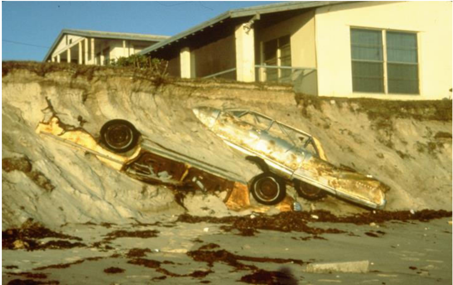
Σχήμα 11.45 Vero Beach, Florida, U.S.A. Σκληρή προστασία με ανορθόδοξα υλικά.... (Τροποποιημένο από SEPМ, 1996).
