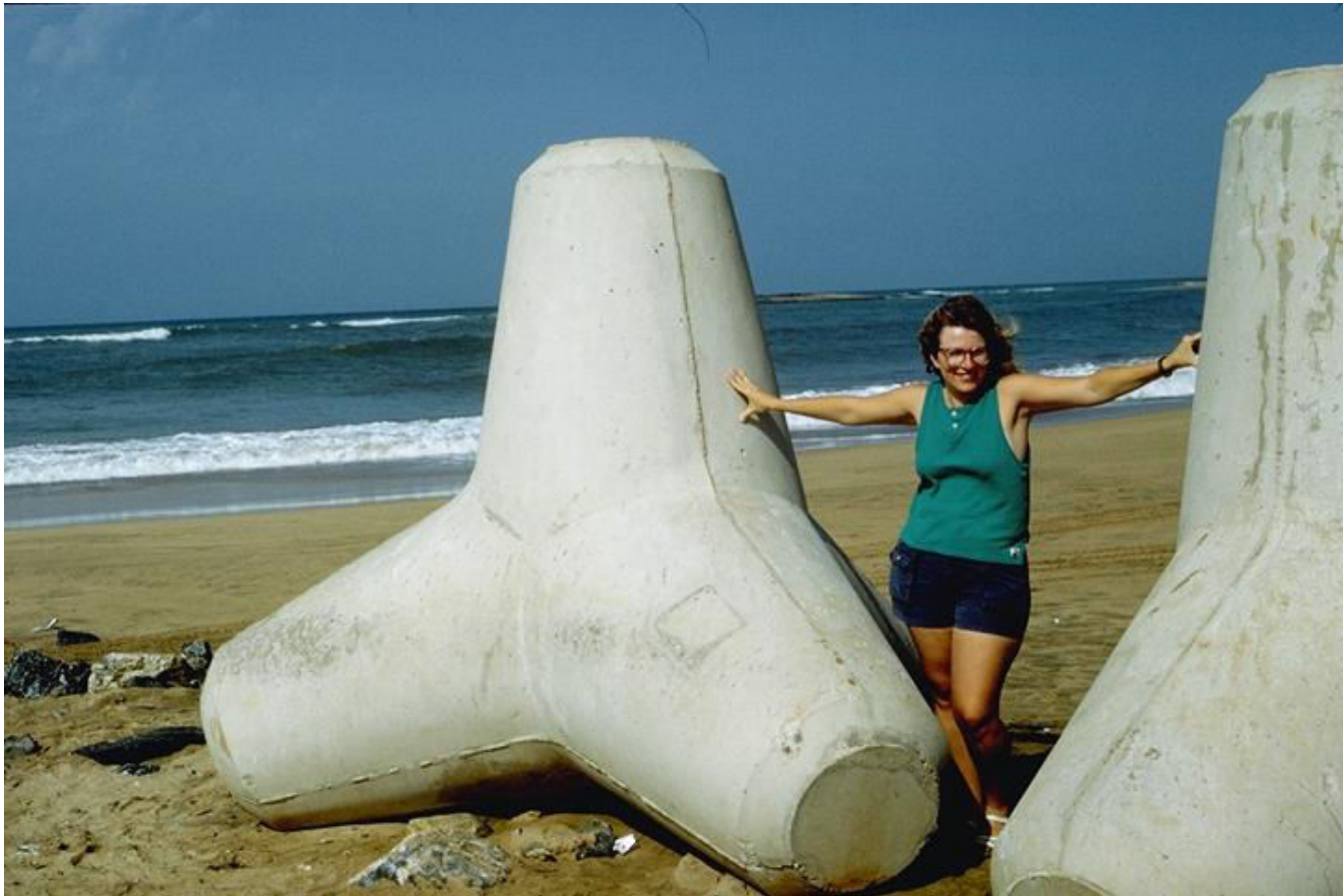
Σχήμα 11.35 Tamara Plage, Rabat, Morocco. Σήμερα οι σκληρές παράκτιες κατασκευές συνήθως κατασκευάζονται από τσιμεντένια τετράεδρα (concrete tetrahedra) τα οποία μπορούν να κλειδώσουν μεταξύ τους και να επιτραπούν κυματική τυρβώδη ροή ανάμεσα τους (σε αντίθεση με την ανάκλαση των συνεκτικών πρανών) με αποτέλεσμα την σχετική απόσβεση της κυματικής ενέργειας. (Τροποποιημένο από SEPM, 1996).
