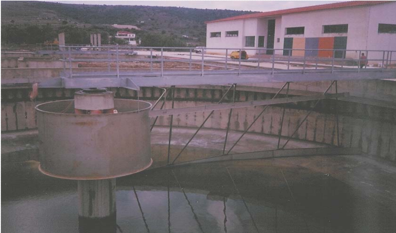
Κυκλική δεξαμενή καθίζησης
