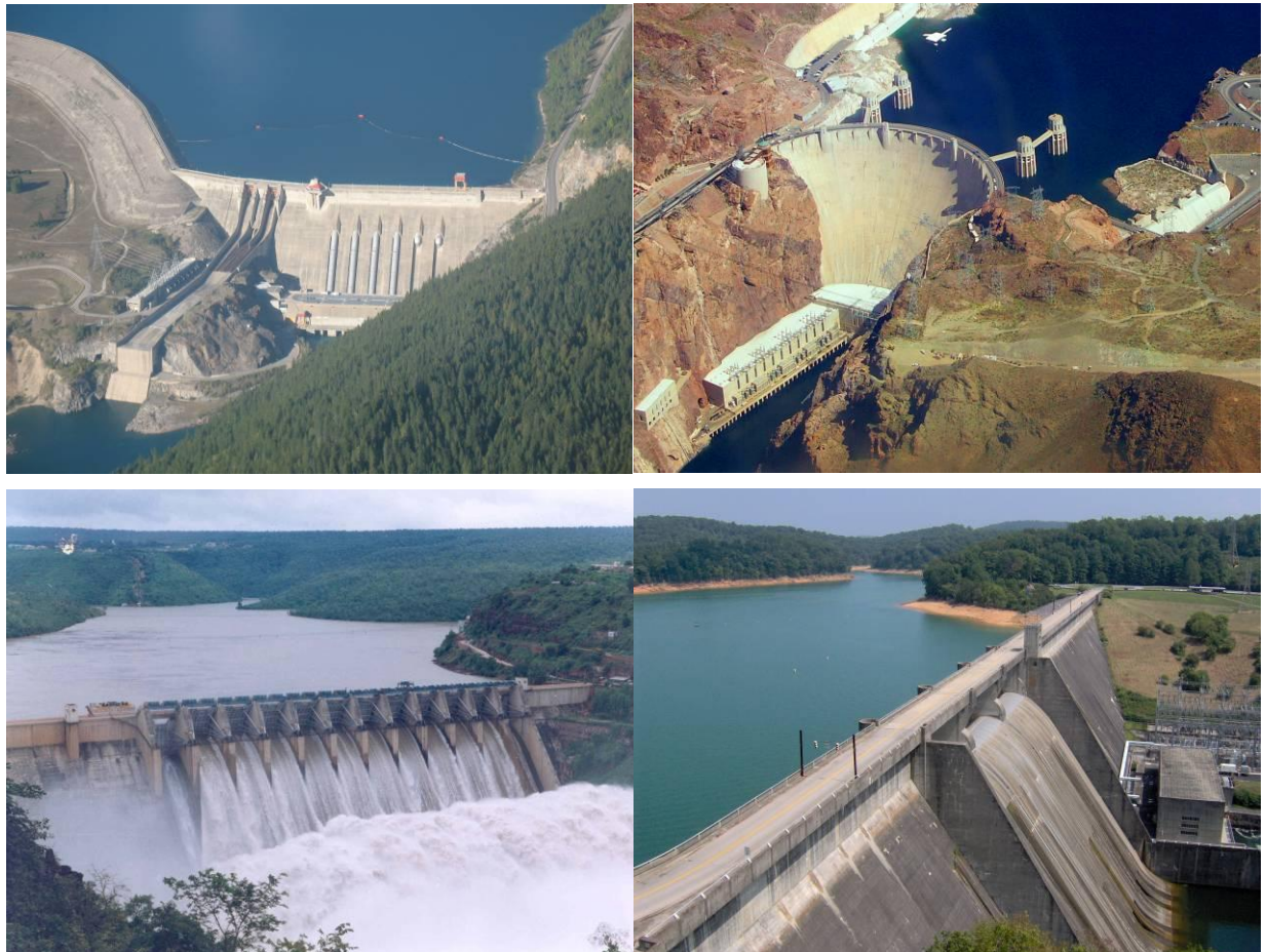
Εικόνα 1.2: Φράγμα Revelstoke στον Καναδά (πάνω αριστερά), φράγμα Hoover στα σύνορα Αριζόνας- Νεβάδας (πάνω δεξιά), φράγμα Srisailem στην Ινδία (κάτω αριστερά), φράγμα Norris στις ΗΠΑ στην πολιτεία Tennessee (κάτω δεξιά). Πηγή: www.wikipedia.com
