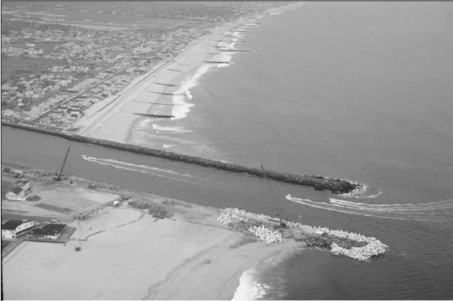
Σχήμα 7.23 N. Carolina coast. Το αποτέλεσμα των προβόλων στην παγίδευση της ιζημεταφοράς παράλληλα προς την ακτή (Τροποποιημένο από SEPM, 1996).
