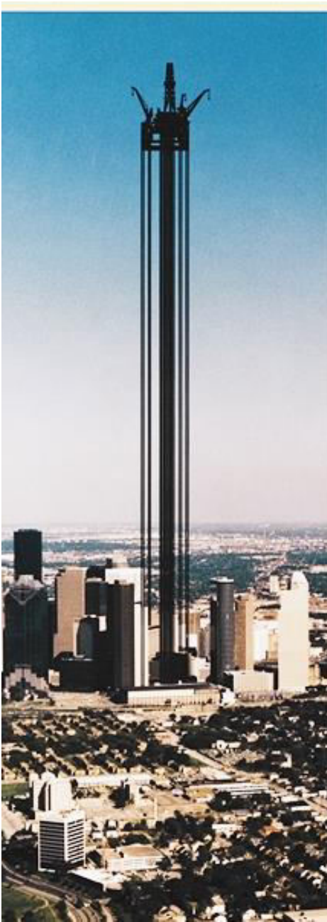
Σχήμα 5.24 Platform Mars and Houston, Texas, U.S.A. Συγκριση της Platform Mars, έτοιμης για καθέλκυση στον Κόλπο του Μεξικού το 1996. Τα ατσάλινα καλώδια είναι σχεδιασμένα να αντέξουν 22 m κύματα και άνεμους 225 km την ώρα. (Τροποποιημένο από SEPM, 1996).
