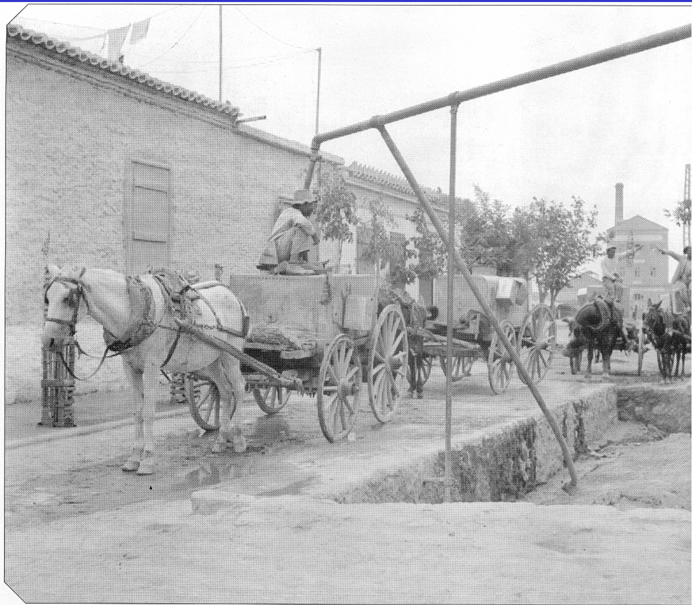
Υδροληψία από αγωγό νερού της ΕΕΥ, φωτογραφία 1930.
