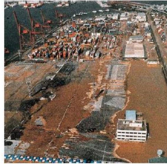
Εικόνα 3.3 Εκτεταμένες ρευστοποιήσεις εδαφών στο λιμάνι του Kobe από τον σεισμό ( M=7,2 ) στο Hanshin – Kobe (Ιαπωνία, 1995)
