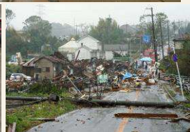
Καταστροφές στην πόλη Ichihara, ανατολικά του Τόκιο, 12/10/2019
