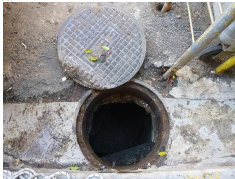
Φρεάτιο στις οδούς Ριανκούρ και Οιπήλου
