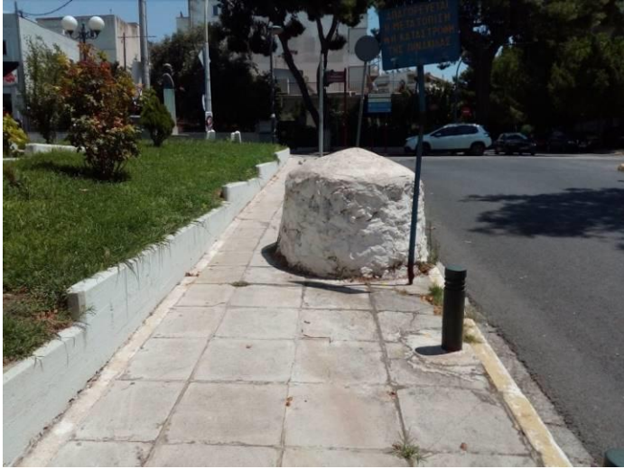
Εμφανές φρεάτιο με κωνοειδή κάλυψη
