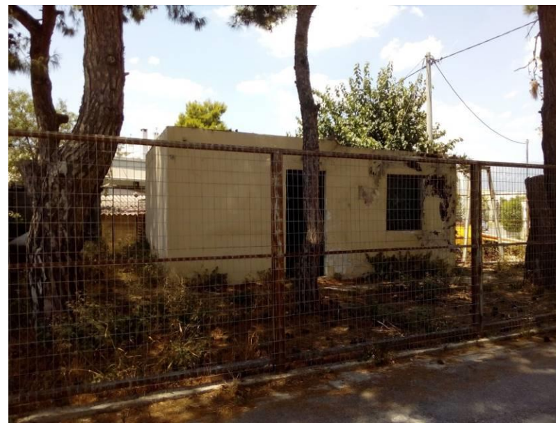
Αντλιοστάσιο στη Μεταμόρφωση
