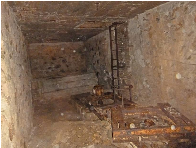
Δήμος Ψυχικού – Πρώην Αντλιοστάσιο Νοσοκομείου Σωτηρίας
