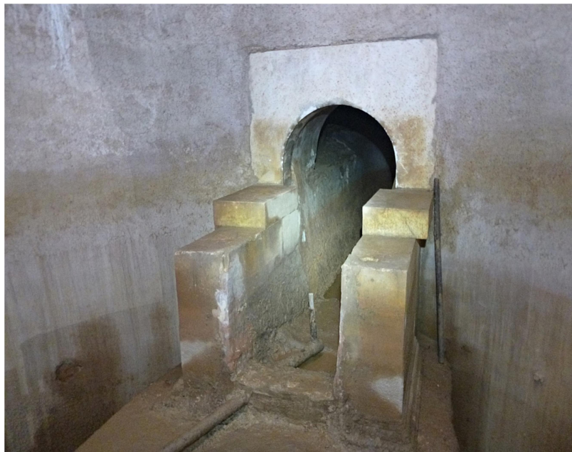
Εικόνα 4.1. Κατάληξη του υδραγωγείου στη δεξαμενή
