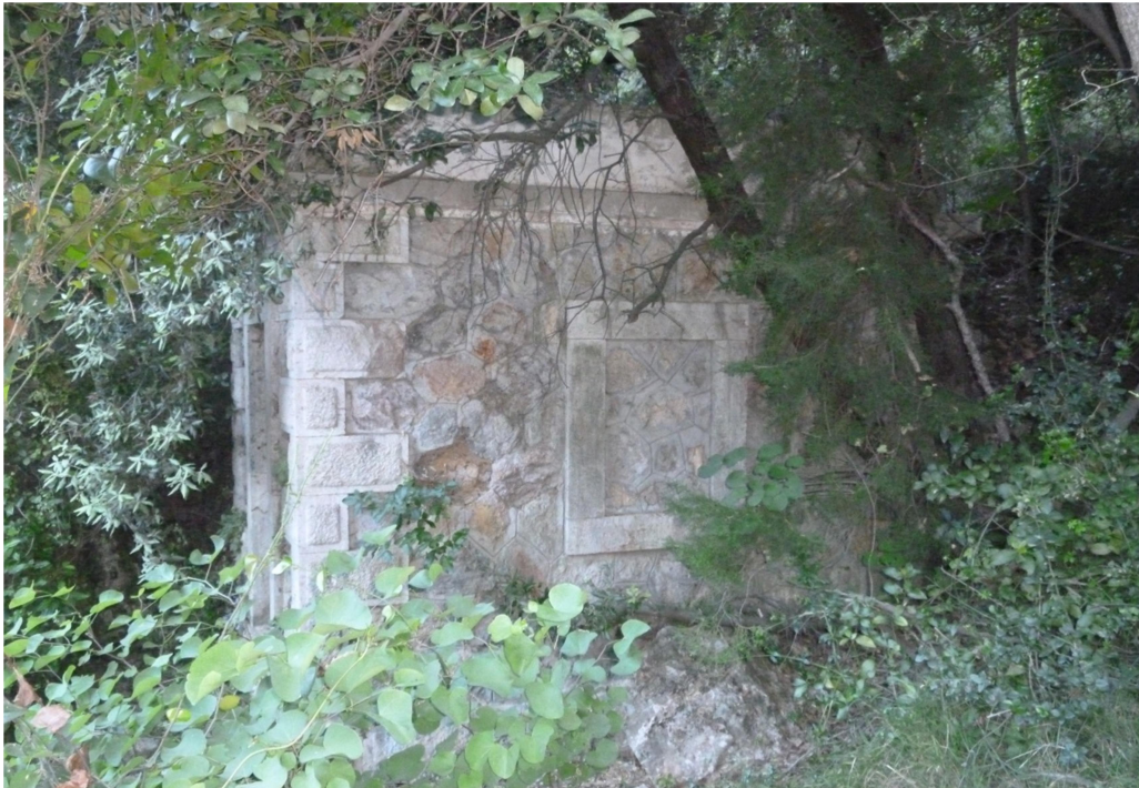
Εικόνα 3.46. Ο οικίσκος όπου καταλήγει η σήραγγα της Κιθάρας
