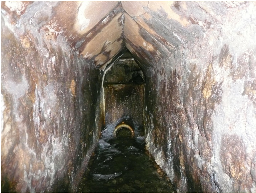
Εικόνα 3.38. Διατομή (0.50 x 1.40 m), το φρέαρ 239 και λεκάνη συλλογής νερού από το τμήμα 6 (εμπρός), το 7 μέσω του μεταλλικού αγωγού (αριστερά) και από το ίδιο το φρέαρ που υδρομαστεύει.
