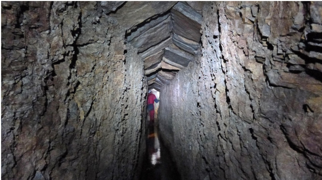
Εικόνα 3.7. Τμήμα υδραγωγείου κοντά στον Άγιο Δημήτριο
