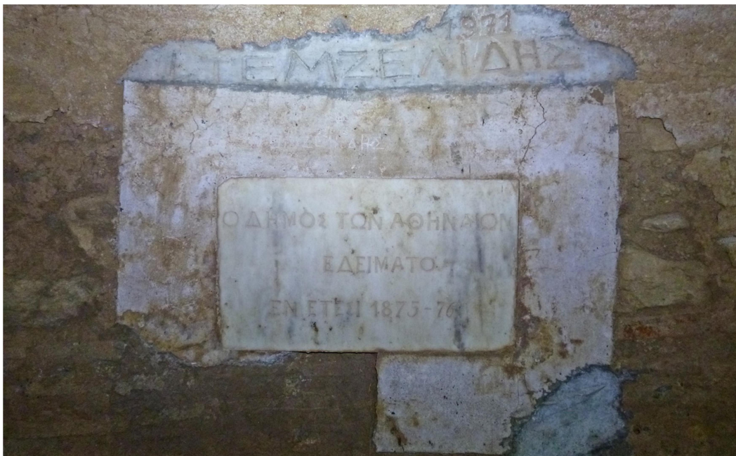
Εικόνα 3.31. Η μαρμάρινη επιγραφή, το λευκό κονίαμα της εποχής της, και η νεότερη επισκευή (1971)
