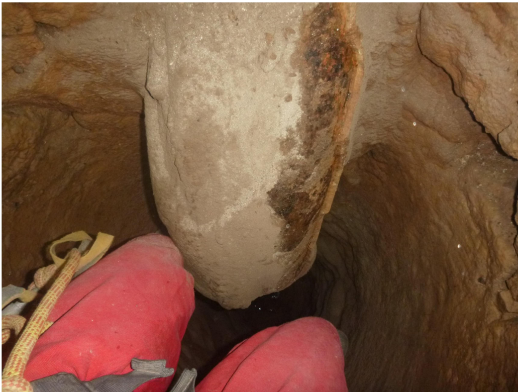
Εικόνα 3.29. Μεταλλικός σωλήνας σχήματος “Γ” διοχέτευε το νερό στο Αδριάνειο (φρέαρ 102)
