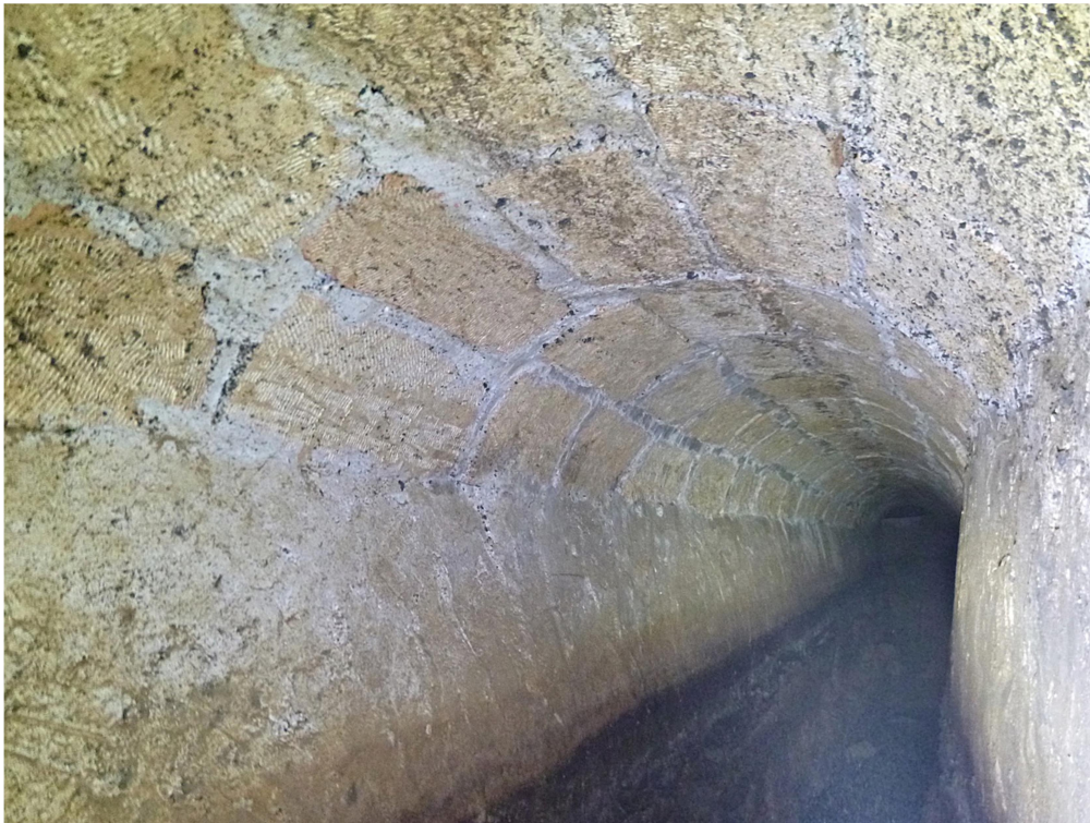
Εικόνα 3.18. Σήραγγα κατάντη του φρέατος 1, στα 13 m εμπρός ο επόμενος υπερχειλιστής
