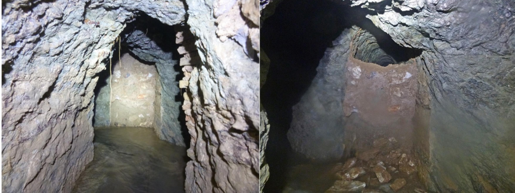
Εικόνα 3.62. Αποσφράγιση της διακλάδωσης του “Πεισιστράτειου” υδραγωγείου προς Κάτω Αμπελοκήπους
