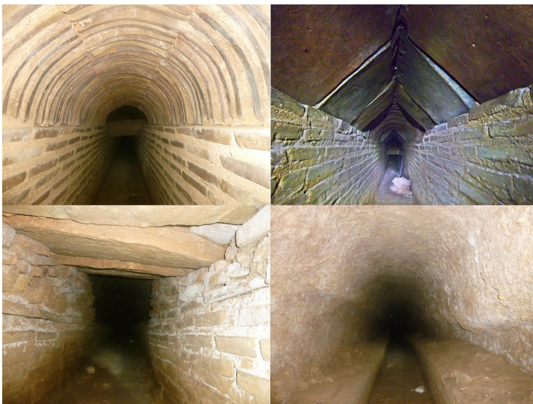
Εικόνα 3.44. Τύποι διατομών της κεκλιμένης στοάς. Η κάτω δεξιά διατομή δεν έχει εντοπιστεί σε άλλο σημείο του υδραγωγείου, από τα τμήματα που ερευνήθηκαν μέχρι σήμερα.
