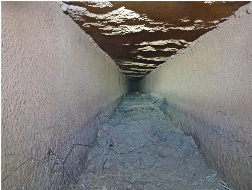
Εικόνα 3.6. Πλακοσκεπές κανάλι τροφοδοσίας της ανοικτής δεξαμενής του 1880
