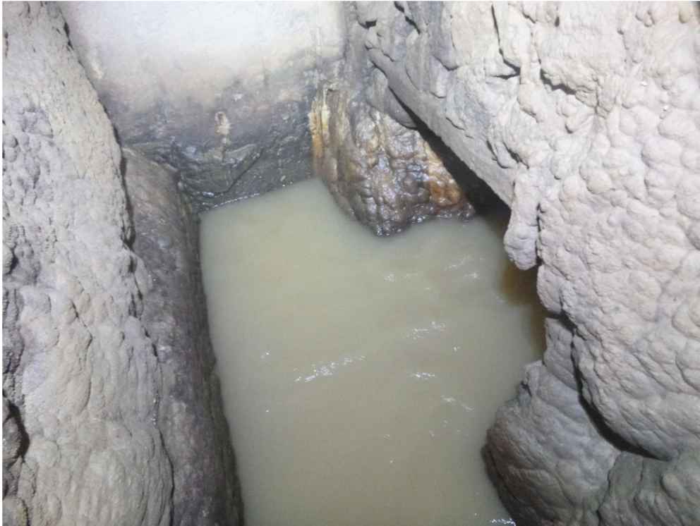
Εικόνα 3.22. Το πέρας της σήραγγας Ριανκούρ και ο εγκάρσιος \varnothing 600 προς τον οικίσκο χλωρίωση
