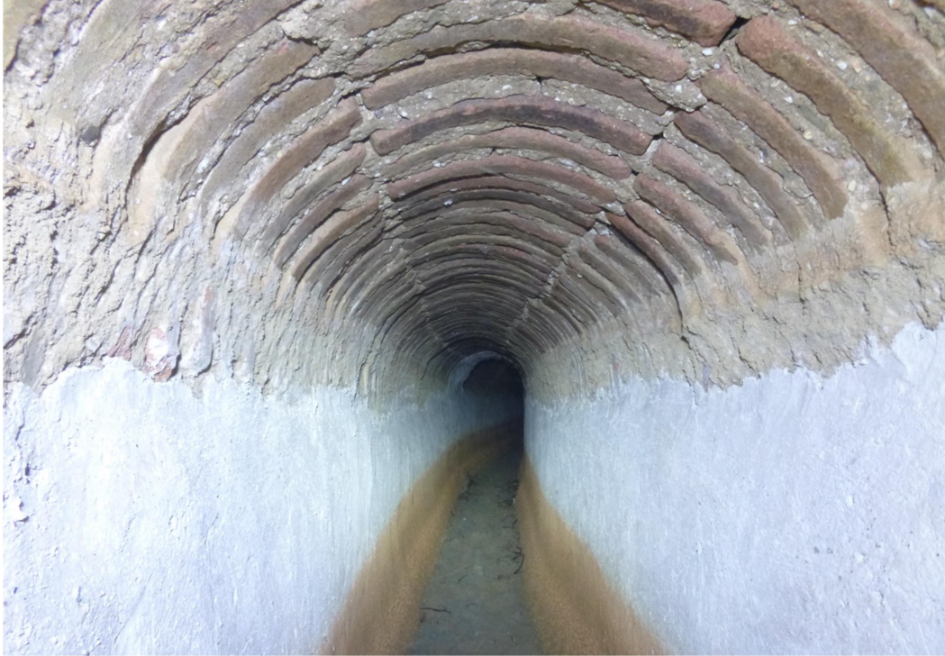
Εικόνα 3.5. Καθαρισμένα και επικαλυμμένα τοιχώματα, διατηρούμενη ρωμαϊκή οροφή
