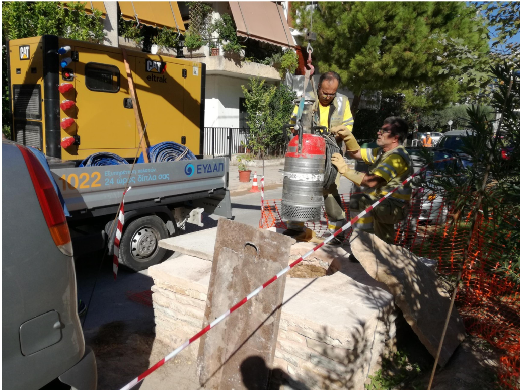
Εικόνα 3.34. Προετοιμασία άντλησης υδάτων στο φρέαρ 103.
