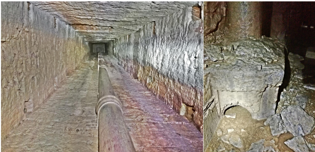
Εικόνα 3.58. Φρέαρ 6 (χαμένο στην επιφάνεια), βάθους 30.8 m με αγωγό που καταλήγει στον πυθμένα
