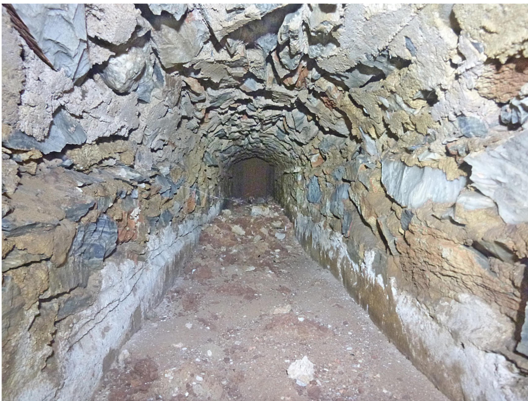
Εικόνα 3.30. Το ανακατασκευασμένο κτιστό χαμηλό τούνελ ανάντη της δεξαμενής
