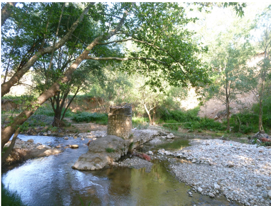
Εικόνα 3.41. Το φρεάτιο του μεταλλικού αγωγού εντός της κοίτης
