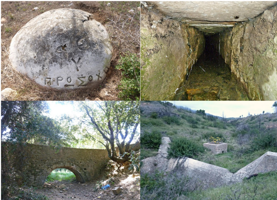
Εικόνα 3.48. Χαρακτηριστικά του κλάδου Βαρυμπόμπης (φανός, κανάλι, υδατογέφυρα, φράγμα)
